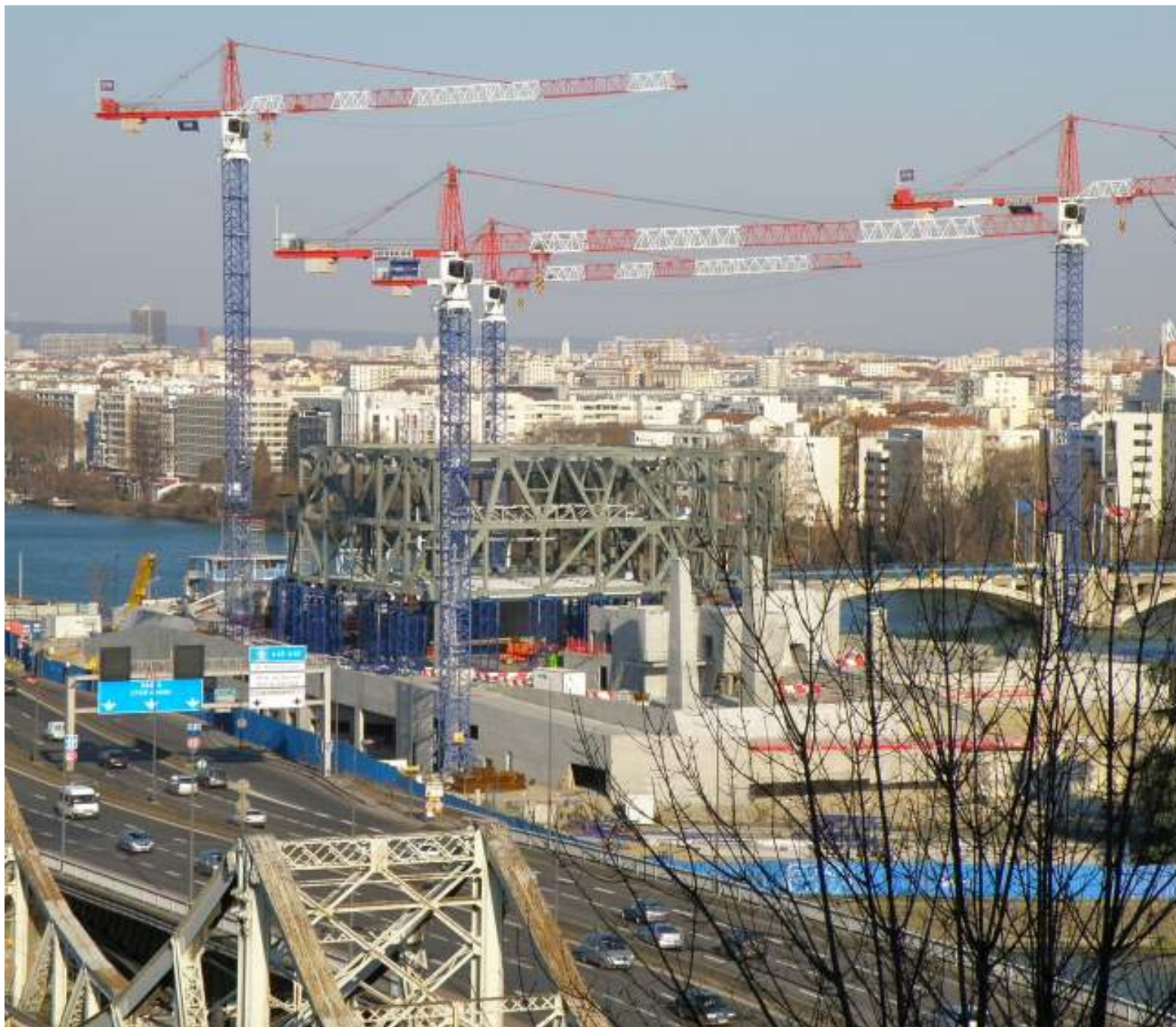
Le musée en construction cc Anne Meyer – Archives BM Lyon
